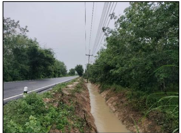
๖. ขุดลอกวัชพืชพร้อมดินตะกอนคูระบายน้ำสายเลียบบถนนเทศบาลชะวอด - ขอนหาด หมู่ที่ ๒ งบประมาณที่เบิกจ่าย ๔๓,๘๐๐.-บาท
