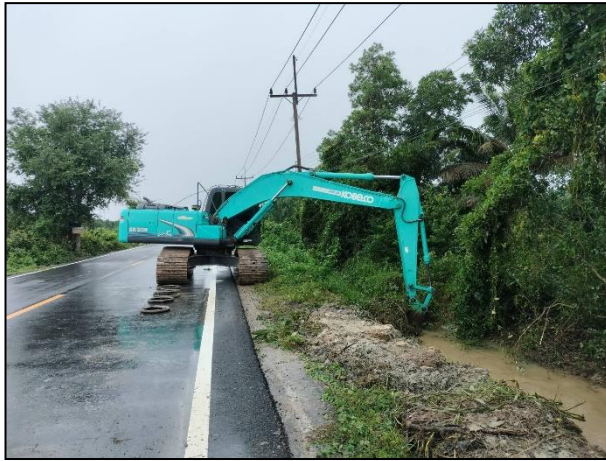
๖. ขุดลอกวัชพืชพร้อมดินตะกอนคูระบายน้ำสายเลียบบถนนเทศบาลชะวอด - ขอนหาด หมู่ที่ ๒ งบประมาณที่เบิกจ่าย ๔๓,๘๐๐.-บาท
