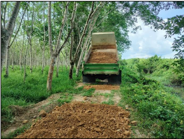
๑๓. วัสดุหินผุ กลบหลุมบ่อถนนสายคันคลองโก หมู่ที่ ๒ งบประมาณที่เบิกจ่าย ๔๔,๘๐๐.- บาท
