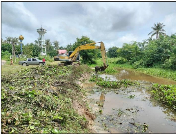
๑๐. ขุดลอกวัชพืชพร้อมดินตะกอนคลองวังขนเจาะ หมู่ที่ ๕ งบประมาณที่เบิกจ่าย ๔๙,๔๐๐.-บาท
