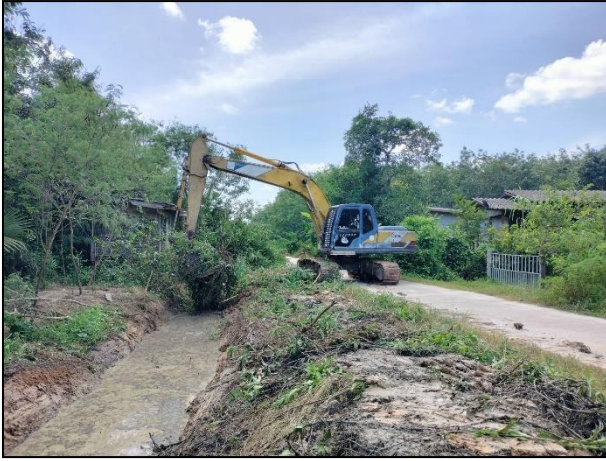
๘. ขุดลอกวัชพืชพร้อมดินตะกอนคุระบายน้ำสายเลียบนถนนรถไฟฝั่งใต้ หมู่ที่ ๗ งบประมาณที่เบิกจ่าย ๗๐,๘๐๐.-บาท
