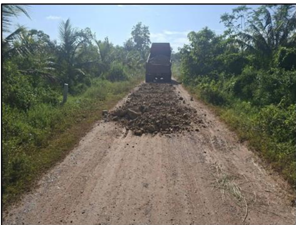
๑๔. วัสดุหินผุ กลบหลุมบ่อถนนสายตรอกค้อ - หนองคลองควาย หมู่ที่ ๓ งบประมาณที่เบิกจ่าย ๓๒,๐๐๐.-บาท
