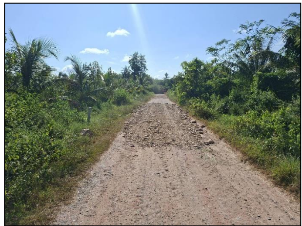
๑๔. วัสดุหินผุ กลบหลุมบ่อถนนสายตรอกค้อ - หนองคลองควาย หมู่ที่ ๓ งบประมาณที่เบิกจ่าย ๓๒,๐๐๐.-บาท
