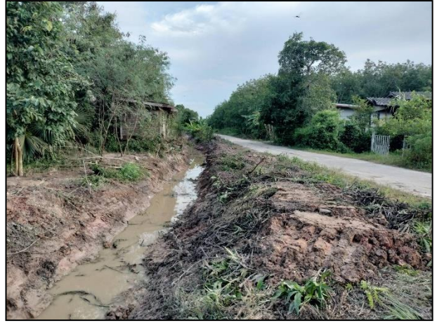
๘. ขุดลอกวัชพืชพร้อมดินตะกอนคุระบายน้ำสายเลียบนถนนรถไฟฝั่งใต้ หมู่ที่ ๗ งบประมาณที่เบิกจ่าย ๗๐,๘๐๐.-บาท
